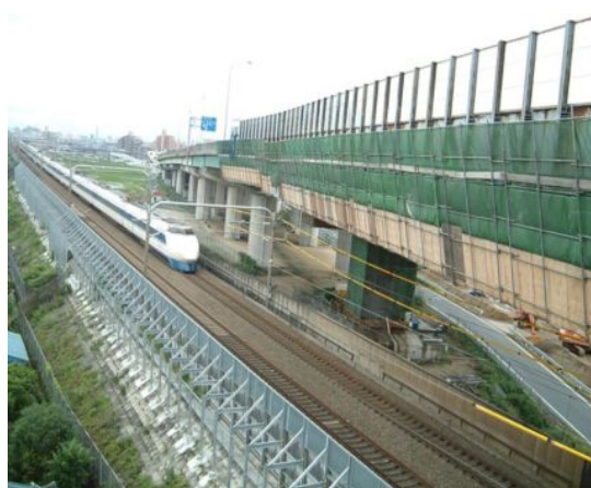
図一20 西中跨線橋全景
