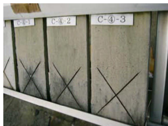
図一12 施工仕様4の5年目
