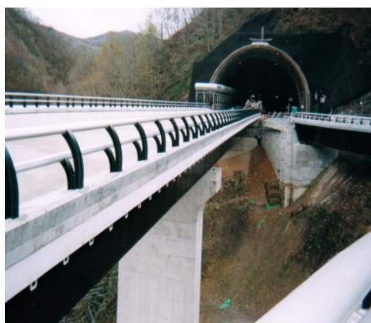
図一18 栗が谷高架橋全景
