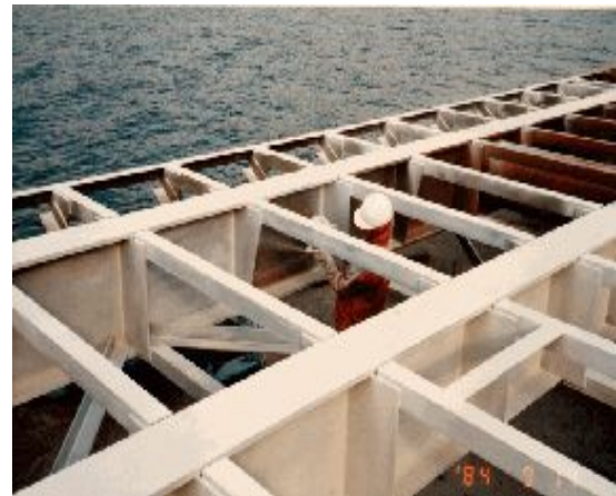
図一六 リシンガンによる吹き付け
