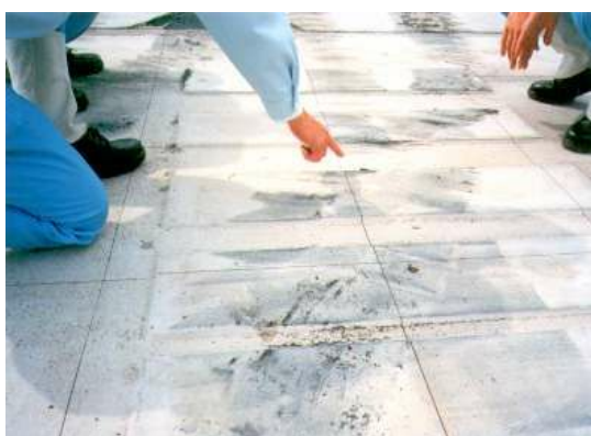
図一16 蛇行走行後の確認作業
